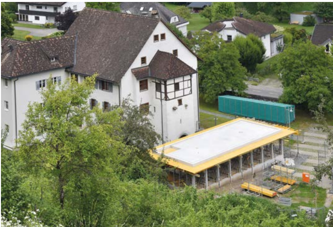
Die Umhausung für den Torkelbaum soll im September fertiggestellt werden.
